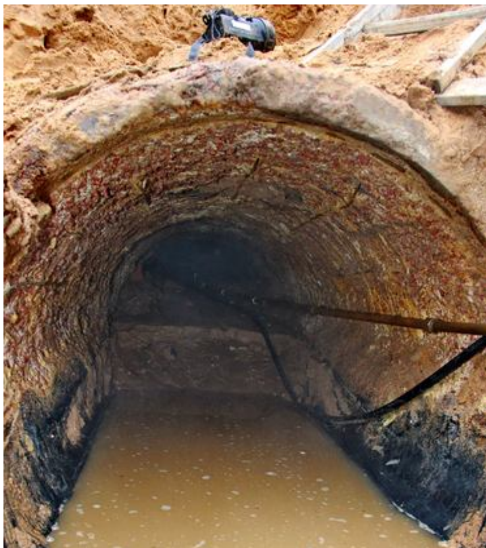
Рис.1. Состояние разгрузочного коллектора по ул. 50 лет ВЛКСМ в г. Барановичи
